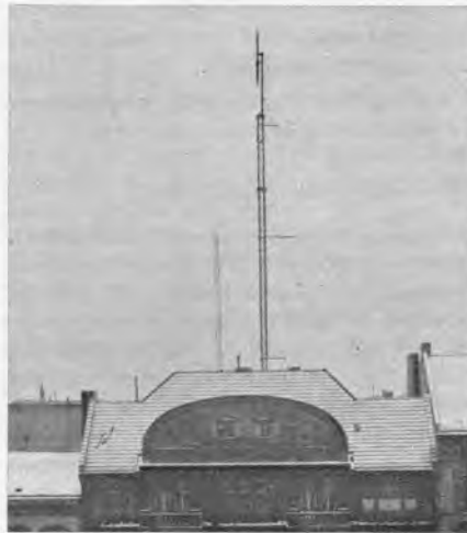
Bild 5. 1931 bereits arbeitete im Telefunken-Haus Berlin, Tempelhofer Ufer 9, ein UKW-Versuchssender. Der auf etwa 7 m Wellenlänge abgestimmte Vertikaldipol bildete die Spitze des vorderen Sendemastes. Für den Empfang dieses amplitudenmodulierten Senders entwickelte die Firma ein Vorsatzgerät, bestückt mit REN 904
